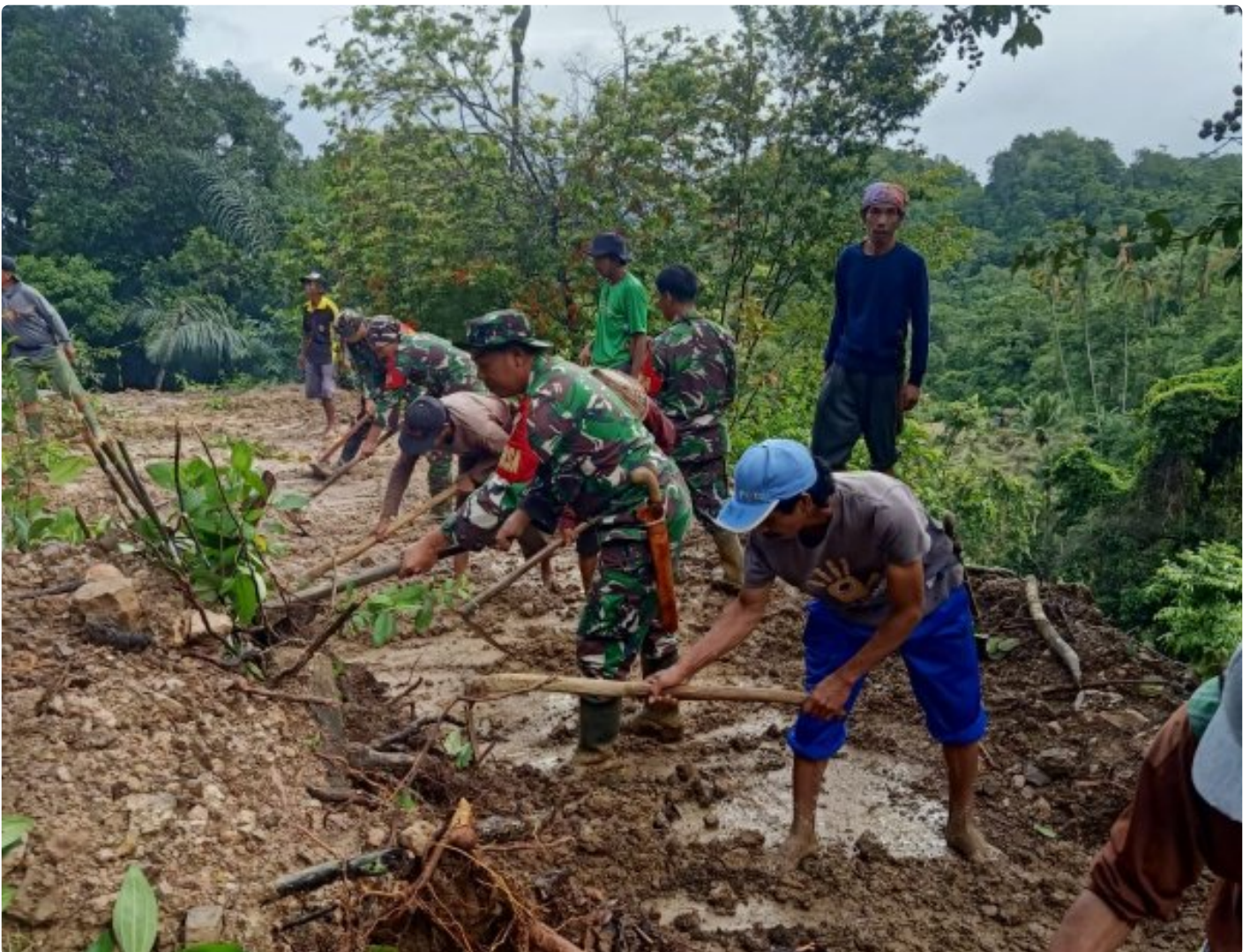
Koramil 1421-01/Balocci Tanggap Bersihkan Jalan Pasca Bencana Tanah Longsor.
